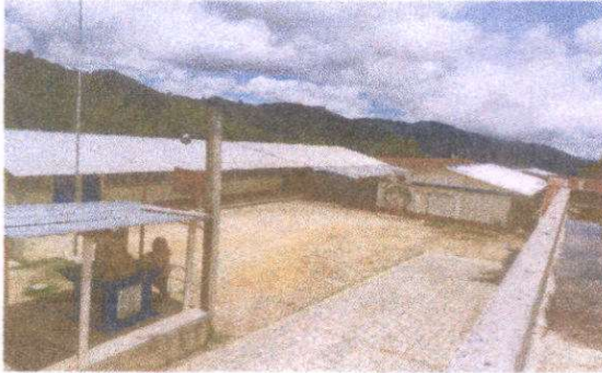
Foto 1: Estado actual del patio
